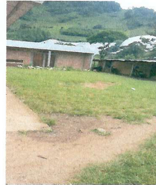
Foto 2: Mejoramiento de losa de patio en el área de recreación de los estudiantes.
